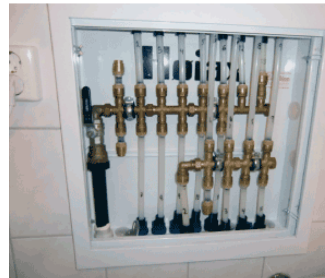
Afbeelding 3: kunststof leidingen met messing fittingen.
